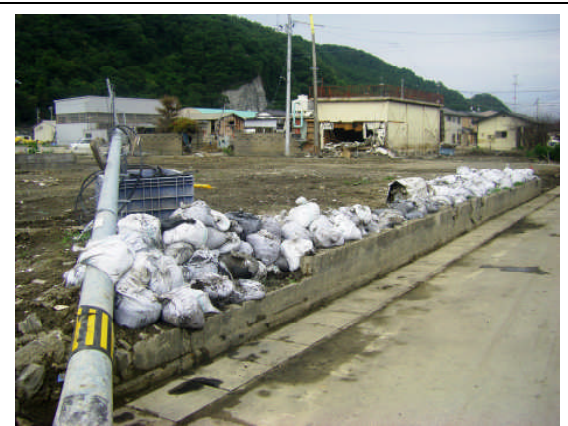
泥を詰めた土嚢袋
