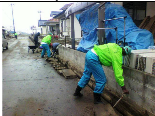
Scooping mud 側溝の泥だし 1
