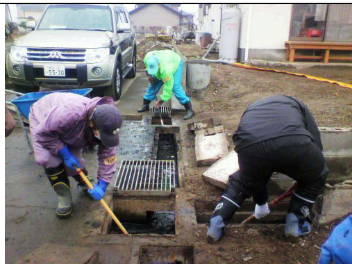
Scooping mud 側溝の泥だし 2
