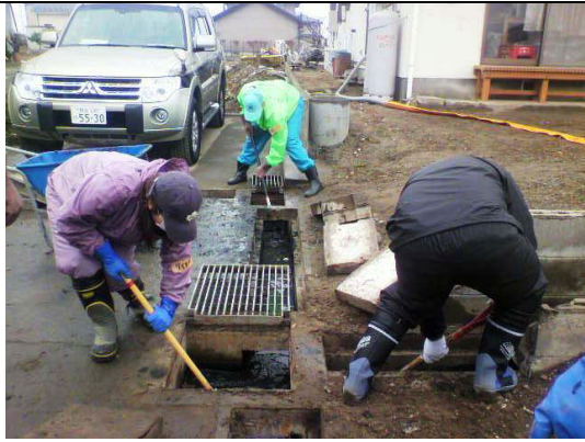
側溝の泥だし2
