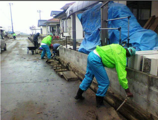
側溝の泥だし1
