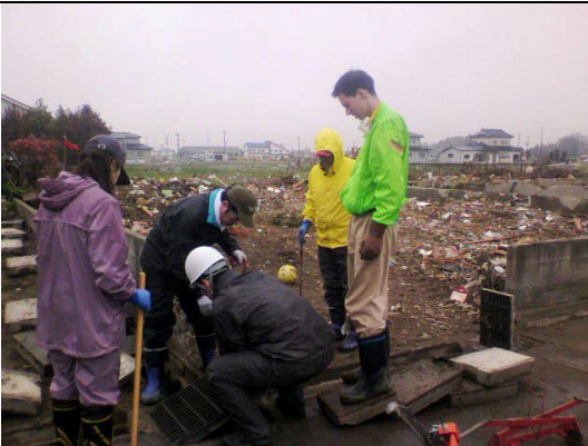
側溝の蓋はずし
