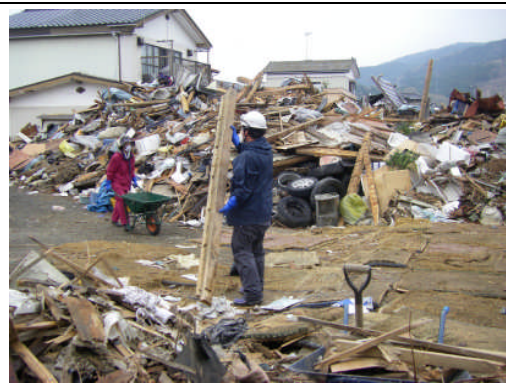
明神社での瓦礫除去作業
