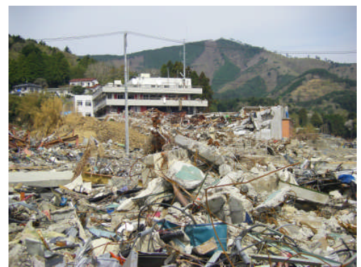
石巻市隣の女川町役場付近
